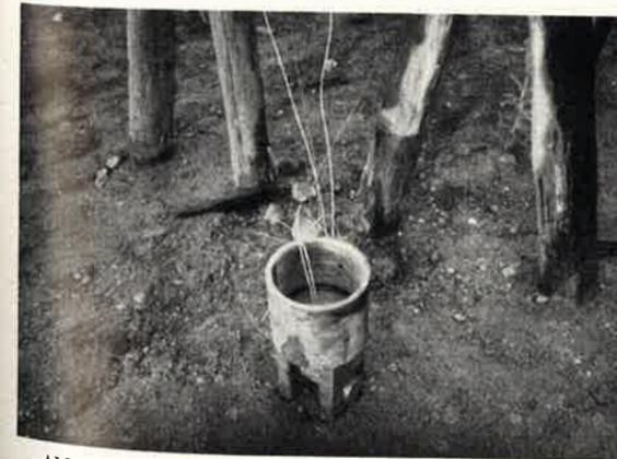
Abb. 11. Haltekopf des Torpedos mit durchgezogenen Zünderdrähten.
