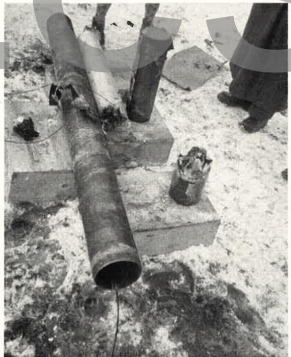
Abb. 16. Zündladerohr, Zündkopf, Trihexogenpatrone und Paraffinpstopfen demonstriert.
