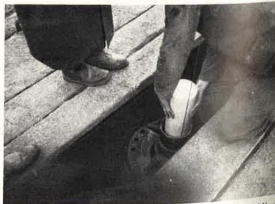
Abb. 9. Aufsetzen der Trihexogenkörper auf die mit Drahtschlinge befestigte untere Patrone.
